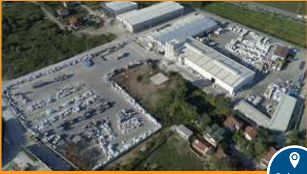
PVC-U Sistem Üretim Tesisi
