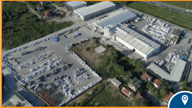
PVC-U Sistem Üretim Tesisi
