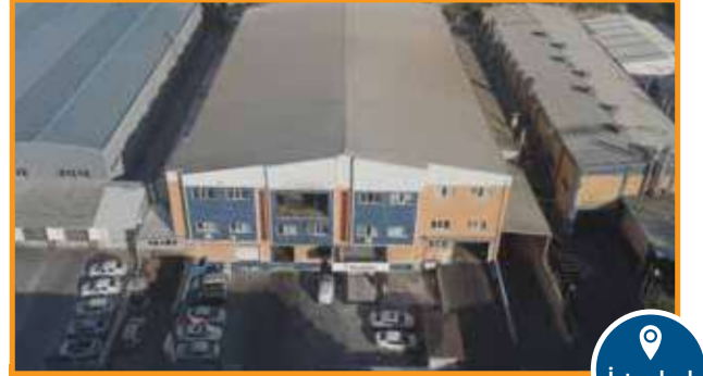
Metal Üretim Tesisi
