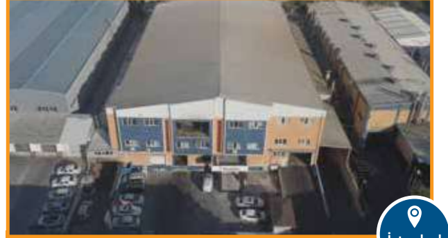
Metal Üretim Tesisi
