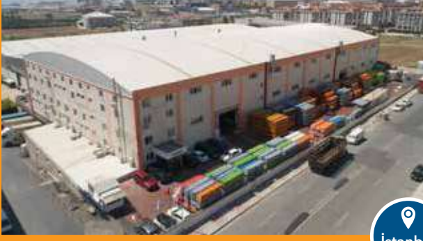
Vana ve PP-R Sistem Üretim Tesisi
